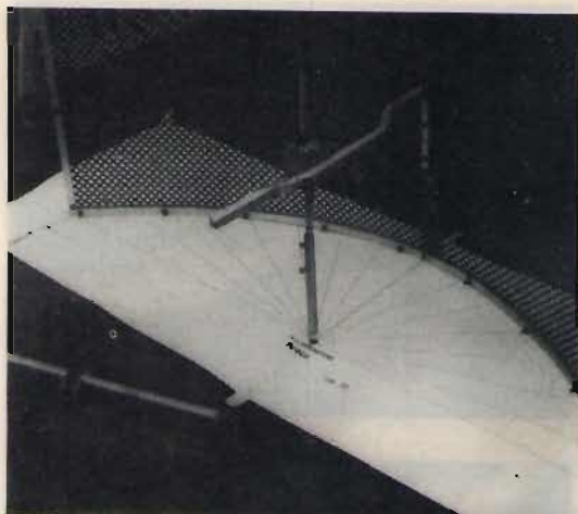
foto 5 Una volta ultimato il montaggio bisognerà controllare che il radiatore capiti esattamente sul fuoco della parabola.
